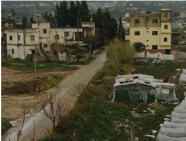
صورة رقم (1) بناء عشوائي قريب جدا" من الطريق - المصدر عمل الباحث .
