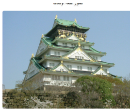
الصورة رقم (8): قلعة «أوساكا» بعد ترميمها
