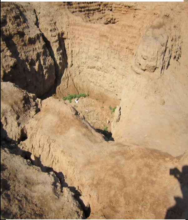
الصورة (٣٠) جانب تجمع مياه الأمطار فوق التلال الأثرية
