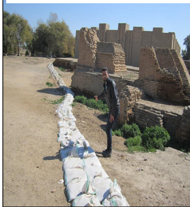
الصورة (٢٩) رصف اكياس مملوءة بالتراب لمنع جريان مياه الأمطار باتجاه مدينة بابل الأثرية
